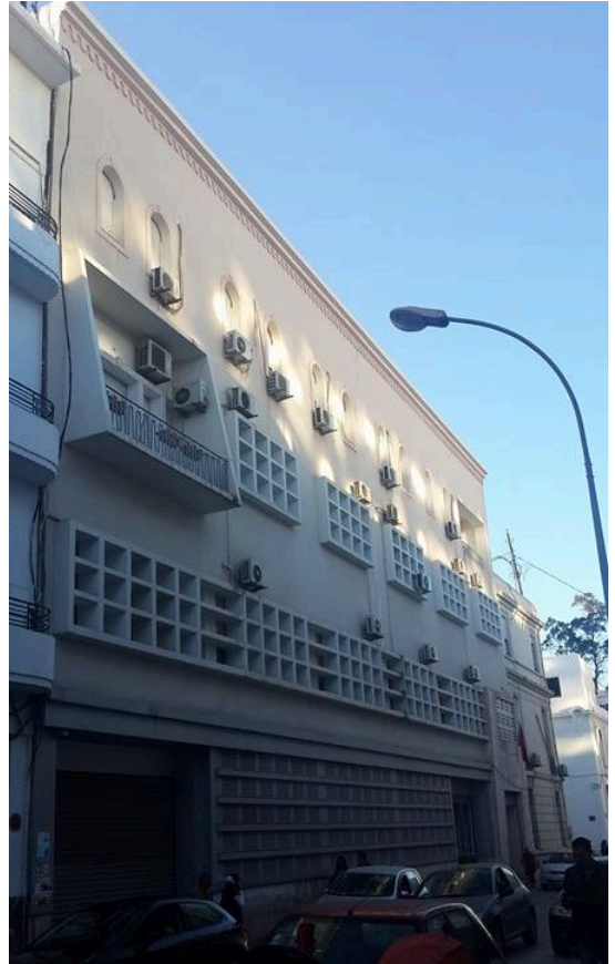
Figure 7: Brise-vents et brise-soleils géométriques parant les façades de l'office du tourisme en haut à gauche, ensuite le central des télécommunications en bas à gauche et finalement la recette des finances à droite. Le jeu des modules résulte de la trame des lamelles en béton.
