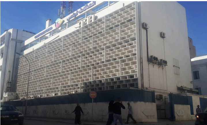
Figure 7: Brise-vents et brise-soleils géométriques parant les façades de l'office du tourisme en haut à gauche, ensuite le central des télécommunications en bas à gauche et finalement la recette des finances à droite. Le jeu des modules résulte de la trame des lamelles en béton.
