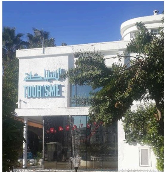
Figure 8: Vitrages en modules répétitifs, ouvertures rectangulaires et grandes baies vitrées, et structure en partie sur pilotis de l'Office du Tourisme
