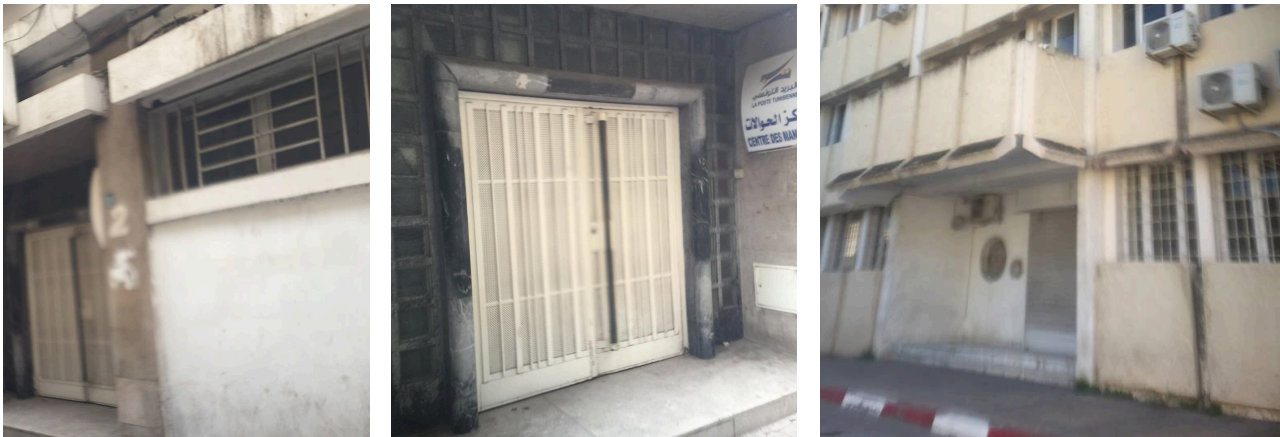
Figure 11: Différents détails de menuiserie en fer forgé en formes géométriques simples: Porte principale et fenêtres en fer forgé du centre des mandats postaux, photos en haut à gauche et au milieu, ensuite fer forgé du port de Tunis, photo en haut à droite, et finalement fer forgé de la porte principale et des fenêtres de l'immeuble de défense en bas
