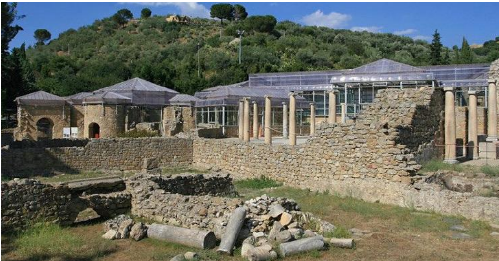
Fig 5: Une vue sur les enceintes
