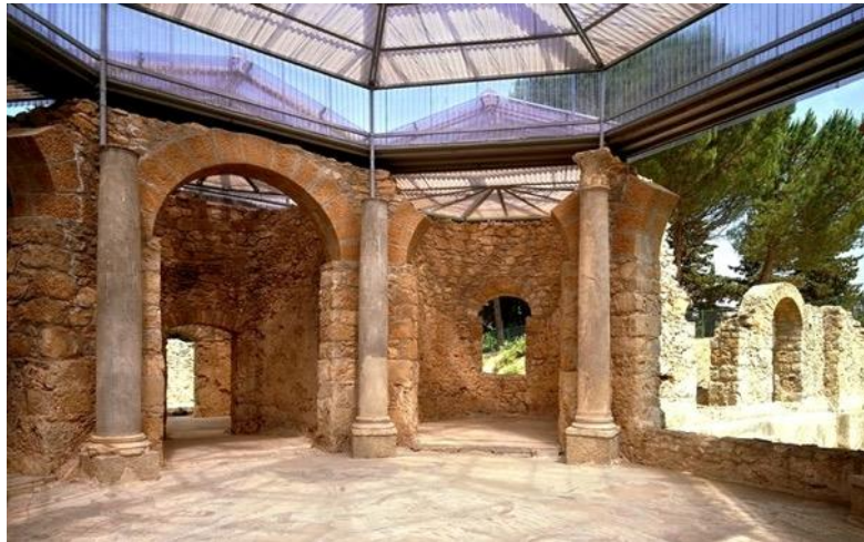
Fig 6: Une toiture translucide pour protéger la mosaïque et connexion intérieur/ extérieur entre les espaces
